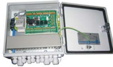
Der Schaltschrank „MINI 24V“ beinhaltet die Klemmenplatine SKP Classic, einen Druckschalter und einen Klemmenblock.
